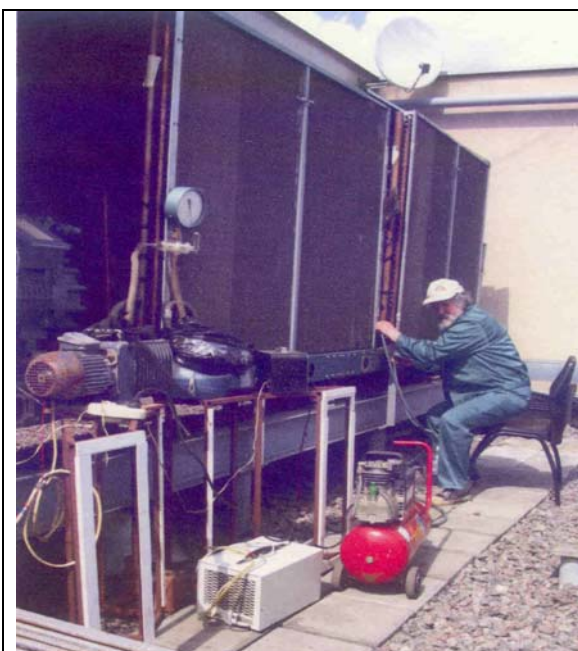
Вакуумная осушка фреоновых контуров холодильной машины фирмы York
