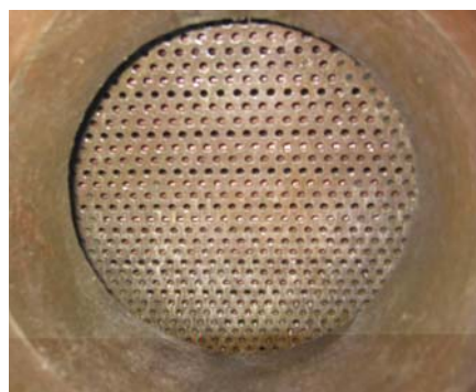
Внешний вид теплообменника холодильной машины МХТМ-2000 до и после реагентной отмывки.
